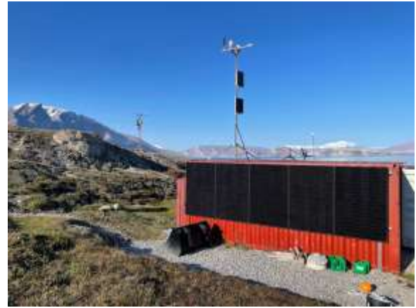
Vi havde et problem med batterierne til vores solcelleanlæg. Systemet skal åbenbart kobles helt fra i vinterhalvåret, når det ikke anvendes. Men med lidt snilde fik vi anlægget op at køre og nød stilheden (uden generatorlyd) på stationen.
