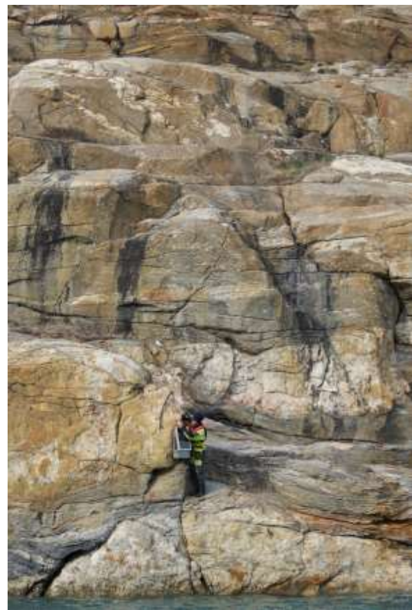
Roeland i gang med at reparere GIOS-lite systemet i Dickson Fjord efter tsunamiødelæggelsen.
