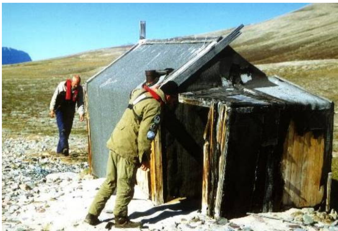
Kap Ovibos hytten før og under restaureringen. Der blev arbejdet ihærdigt med påsætning af tagpap. Ny dør blev lavet og isat. Vinduet blev repareret og skodde monteret.
