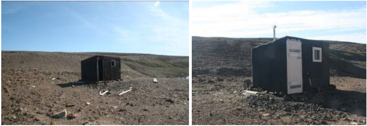
Mellemhuset [367-2] i Loch Fyne før og efter reovering.
