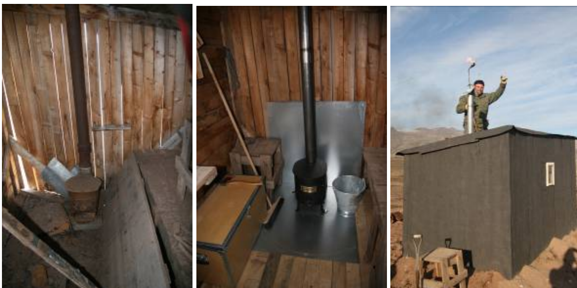
Til venstre og i midten: Det indvendige af Norma hytta [411-2] før og efter renovering. Til højre: Anders Ibsen i gang med påsvejsning af tagpap.
